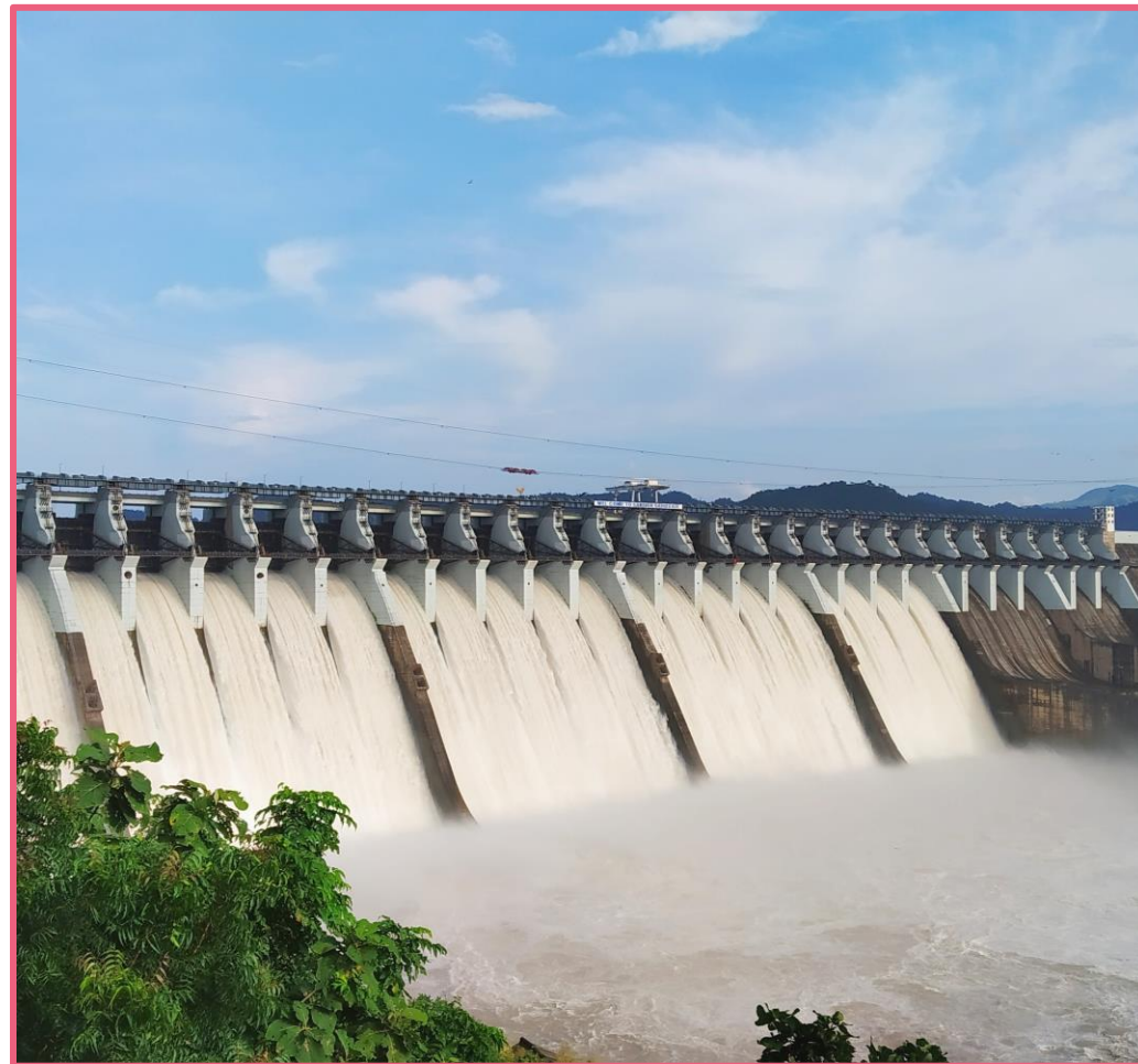
A barragem de Sardar Sarovar, na Índia, é um exemplo da modernização energética asiática.
