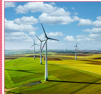
Parque eólico na Alemanha.
