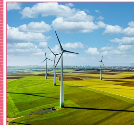
Parque eólico na Alemanha.
