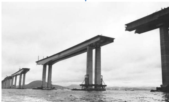
Construção da ponte Rio-Niterói.
