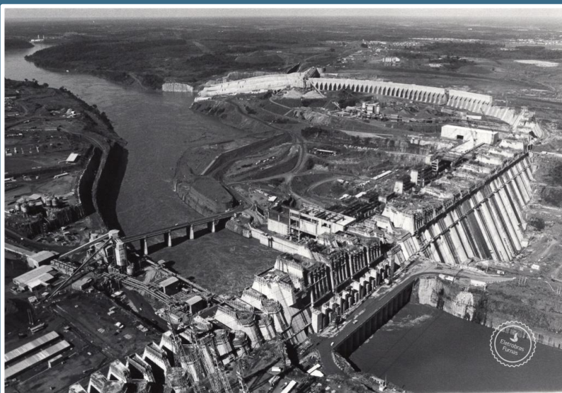
Construção da Usina Hidrelétrica Itaipú Binacional
