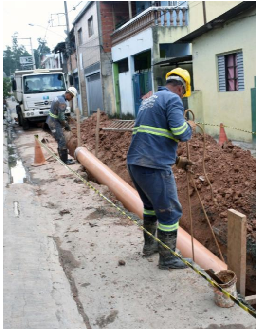
Obra de saneamento básico na cidade de Cajamar.
