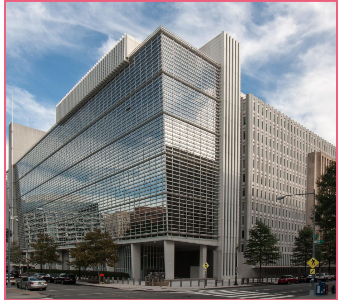
Edifício da sede do Banco Mundial em Washington DC, EUA.
