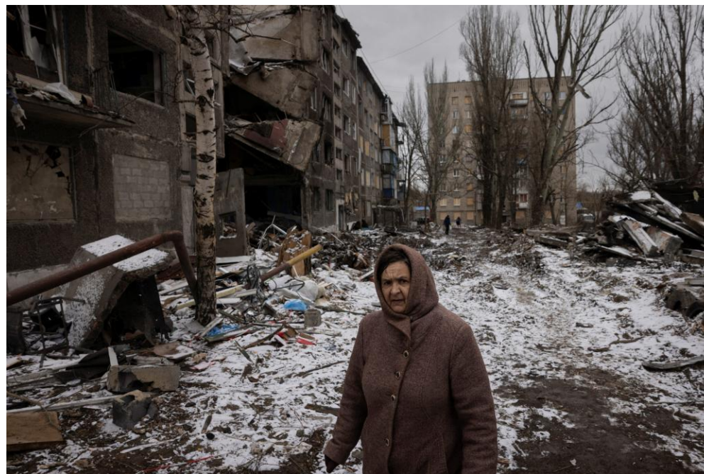
Mulher caminhando entre edifícios destruídos por ataque russo na cidade de Avdiivka, na Ucrânia.
