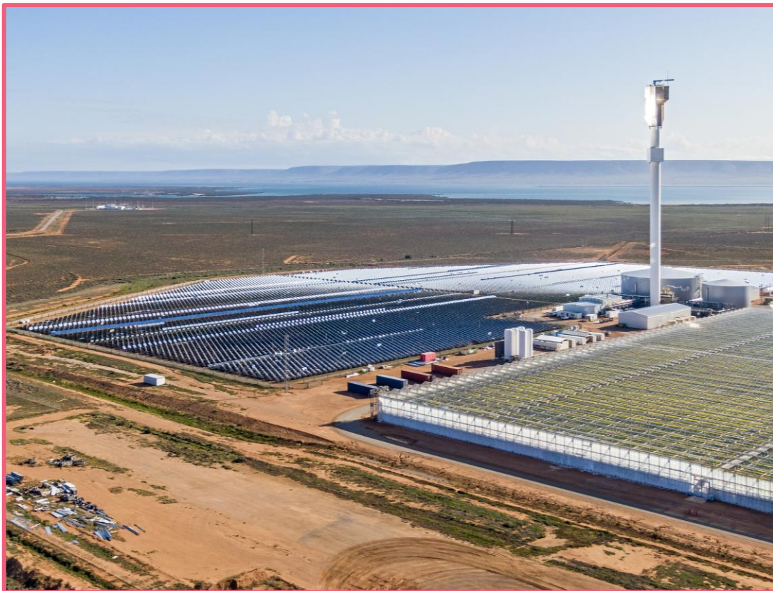
Usina solar em Port Augusta, Austrália. O sistema gerar eletricidade e dessaliniza água do mar para irrigação de estufas agrícolas.
