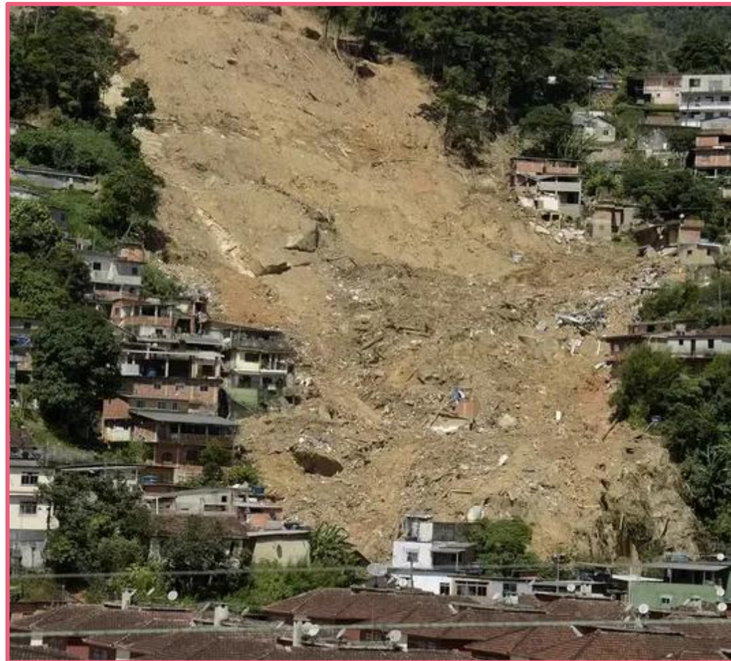
Deslizamento de morro em Petrópolis – RJ.
