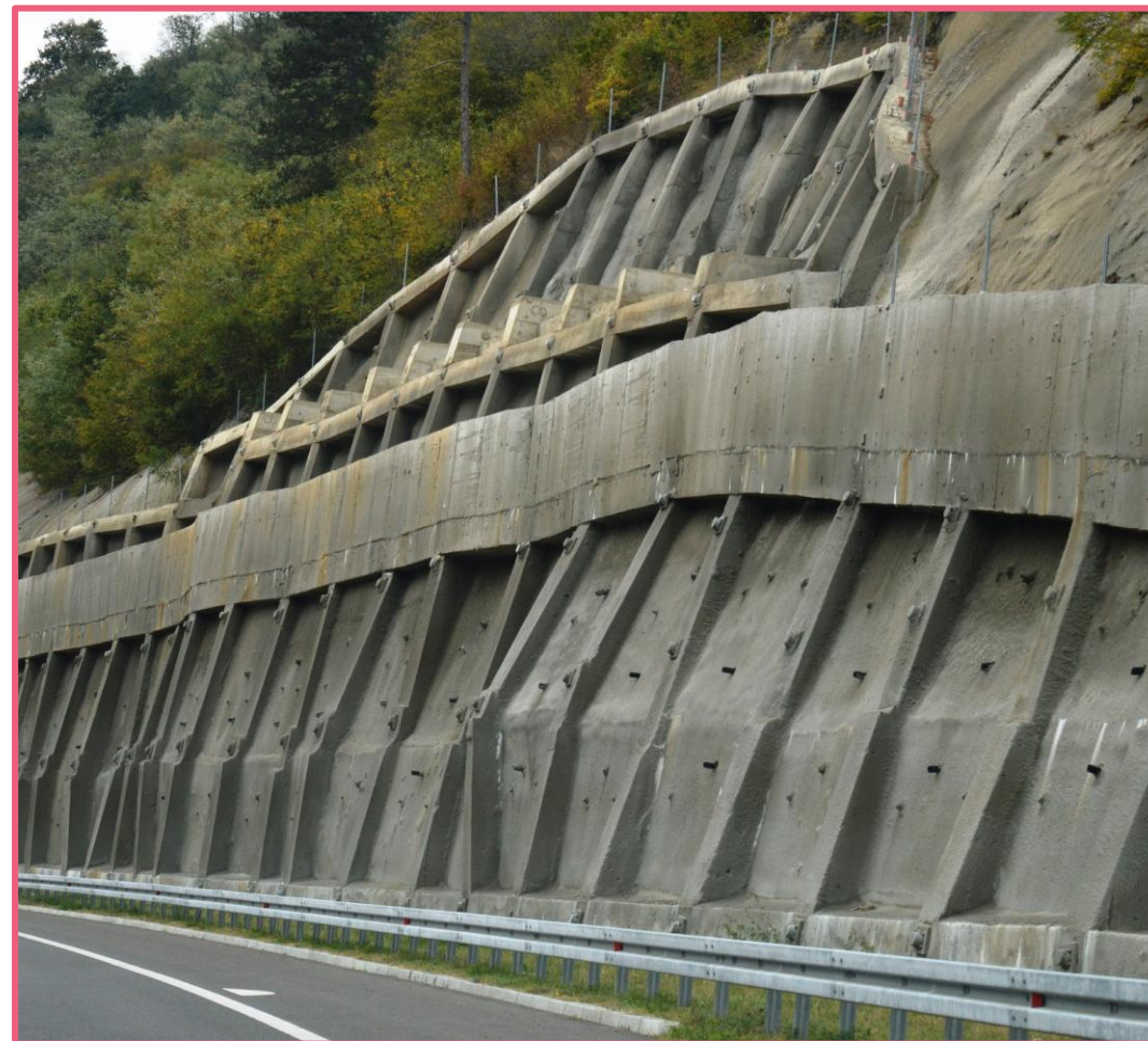
Obra de contenção de encosta.
