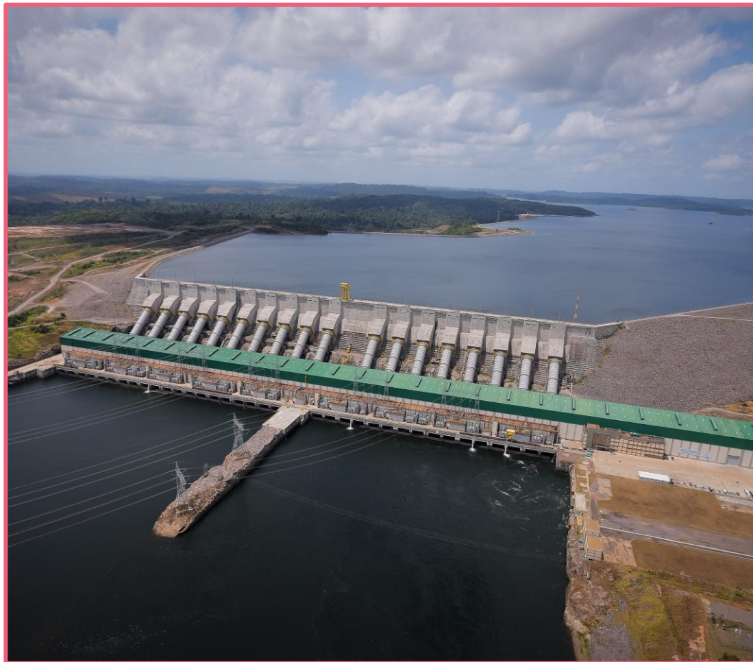
Imagem 6 – Usina Hidrelétrica de Belo Monte, no Rio Xingu (PA).
